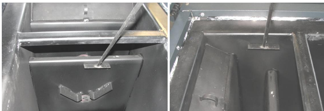
Slika 6.2. Čišćenje pepela iz toplovodnog kotla
